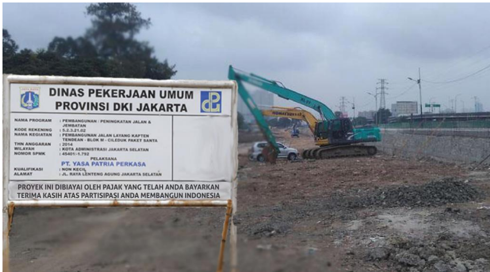
Gambar IX.2 Pembayaran pajak sebagai salah satu bentuk kepedulian sosial demi kepentingan bersama. Salah satu bentuk penggunaan dana pajak yang telah dibayarkan adalah untuk biaya pembangunan jalan
